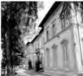
L'ex casa di riposo di via Roma
