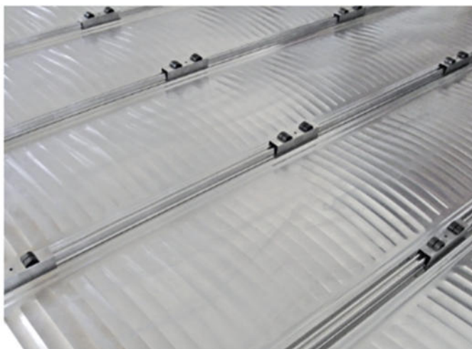
Foto esemplificativa – sistema di ancoraggio su copertura in lamiera pressopiegata
