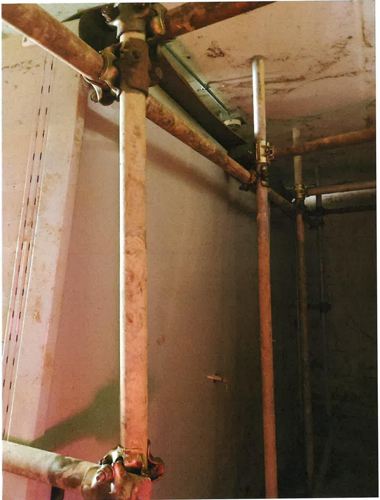
Fig. 5: dettaglio impalcature per sostenere l'ultimo compact dell'Archivio Storico.
