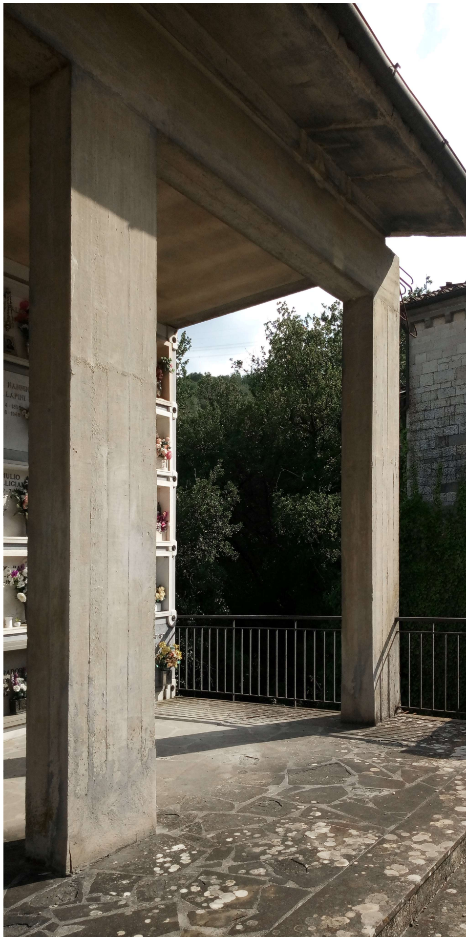
Vista verso monte della zona di intervento per realizzazione di nuovi ossari presso il Cimitero di Lucciano (Stato Attuale)
