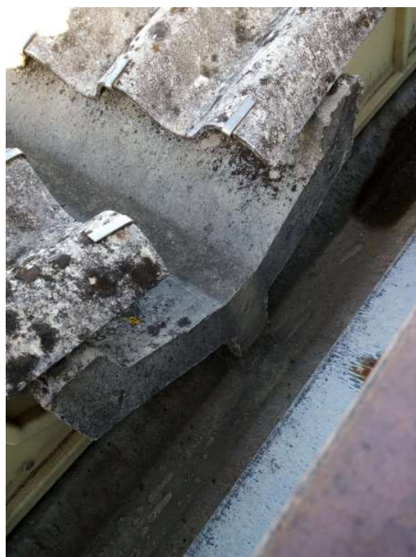
Particolare attacco pannelli fibrocemento-estradosso travi in C.A.P.
