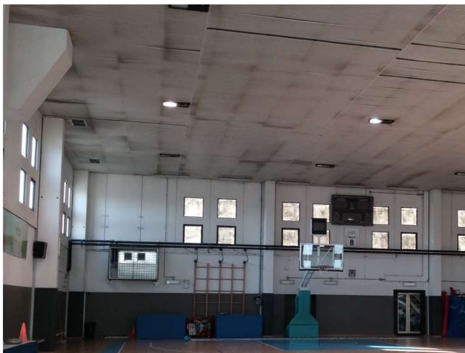
Locale palestra – Visibili segni di deterioramento del controsoffitto
