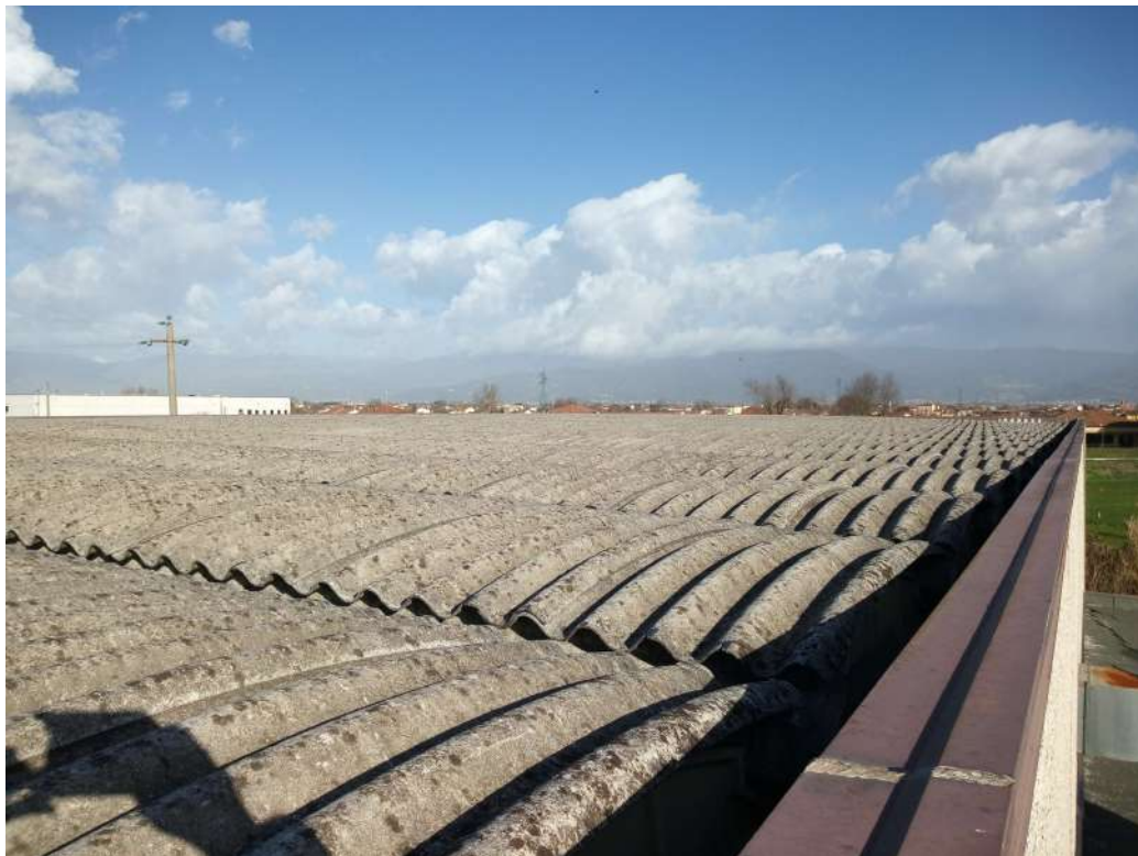
Copertura esistente in fibrocemento
