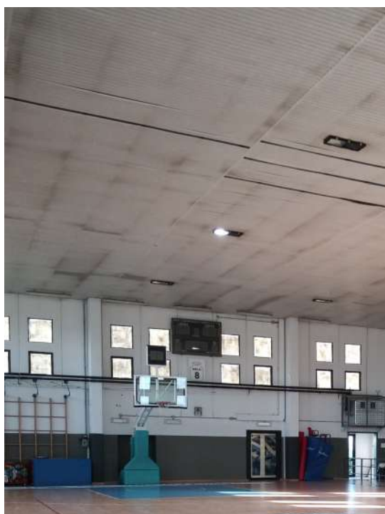
Controsoffitto con corpi illuminanti esistenti
