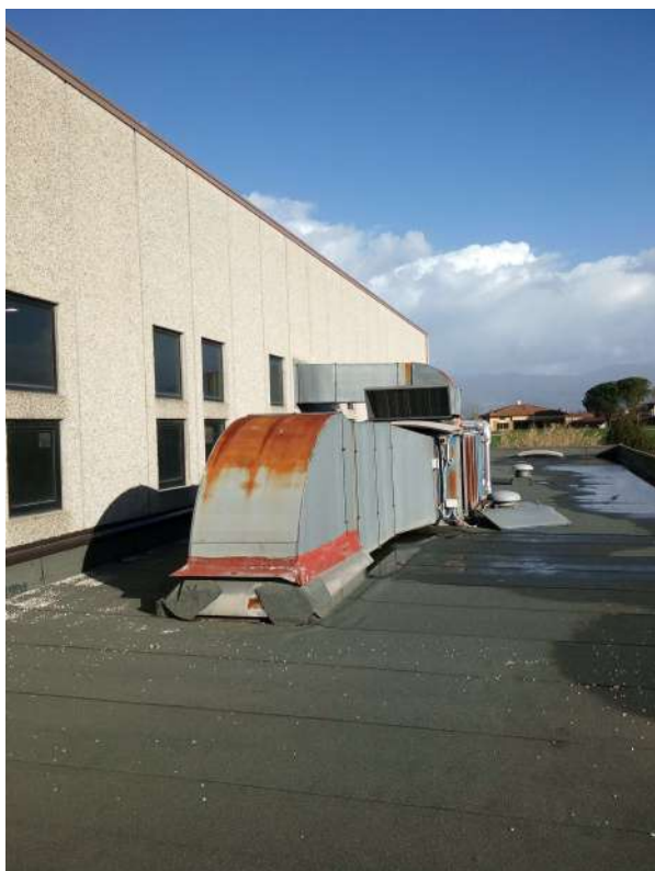
Impianto di areazione esterno da rimuovere
