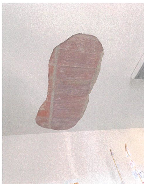
Distacco intonaco presso M. Hack di Casini
