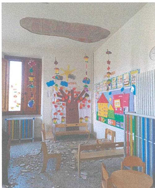
Distacco intonaco presso M. Hack di Casini
