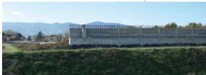
Il cantiere al ponte sulla Dogaia
