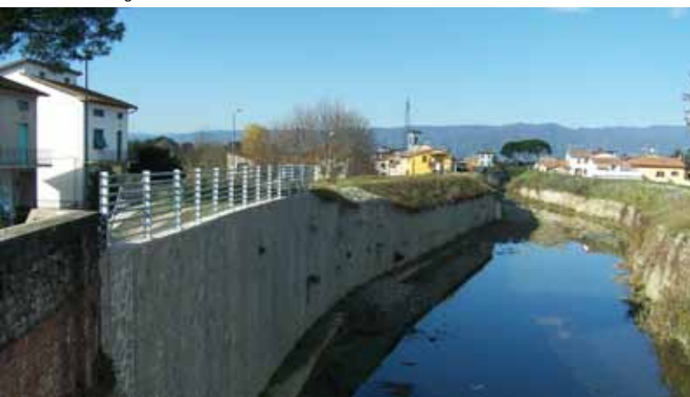
Lavori sull'argine dell'Ombrone a Ferruccia
