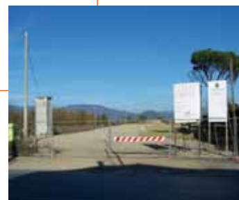
Il cantiere da via Firenze
