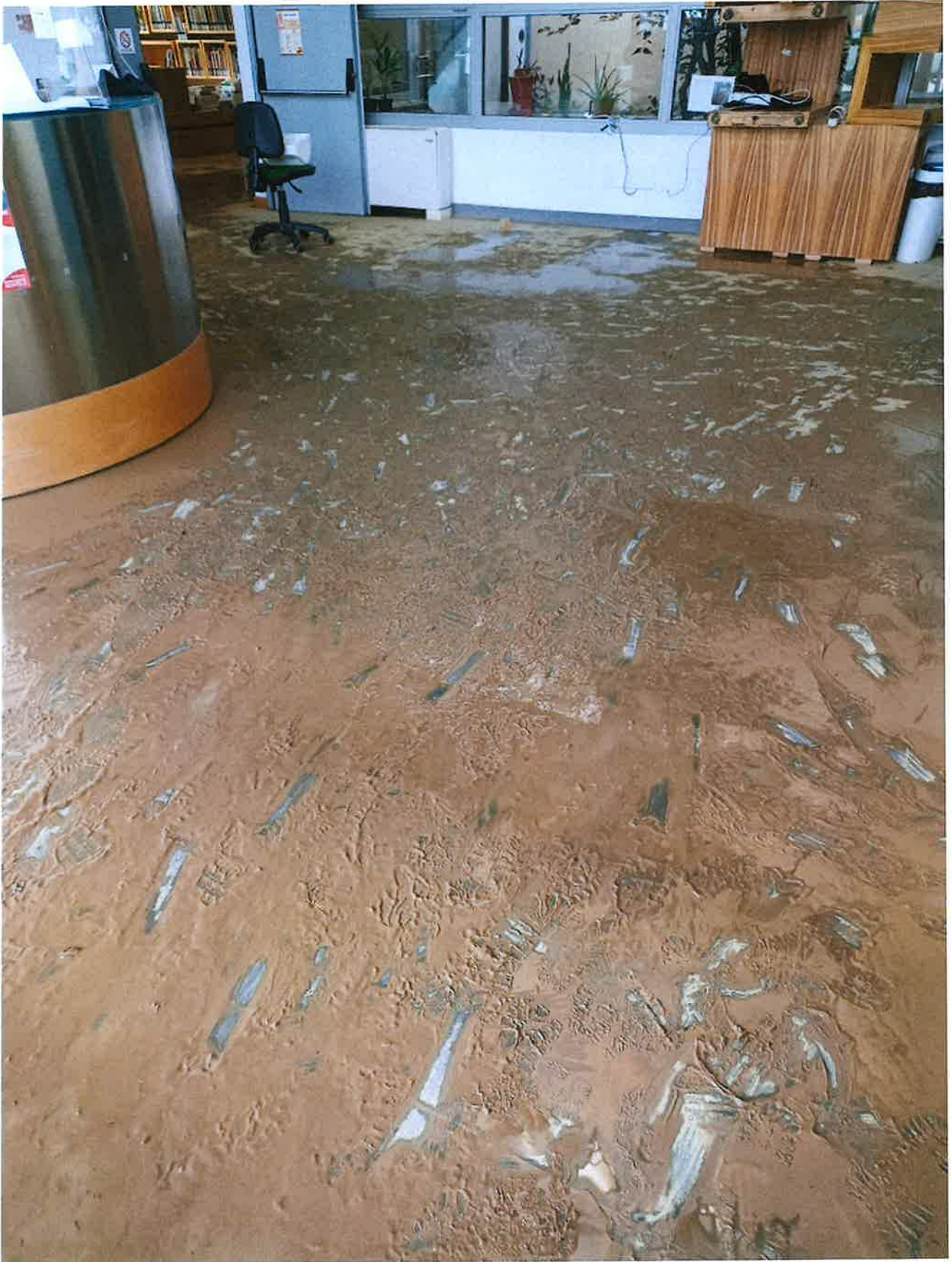
Fig. 6: pavimento ingresso, pomeriggio 3/11/2023
