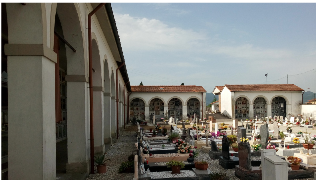
Foto 5 - Veduta interna del Cimitero di Ferruccio
