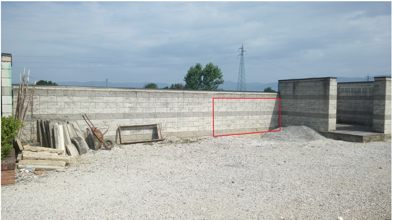
Foto 13 - Localizzazione intervento di realizzazione dei nuovi ossari presso Cimitero di Vignole
