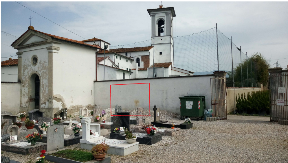
Foto 7 - Localizzazione intervento di realizzazione dei nuovi ossari presso Cimitero di Ferruccia
