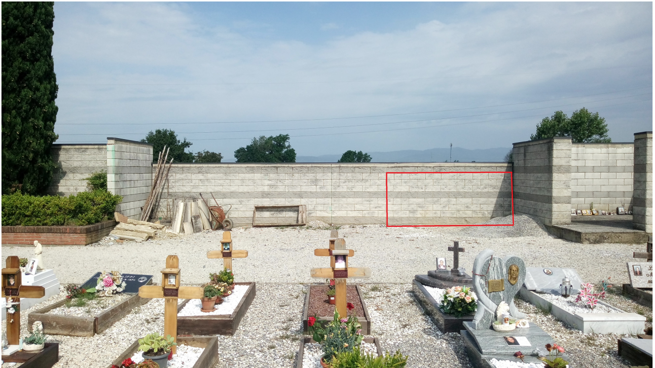
Foto 12 - Localizzazione intervento di realizzazione dei nuovi ossari presso Cimitero di Vignole
