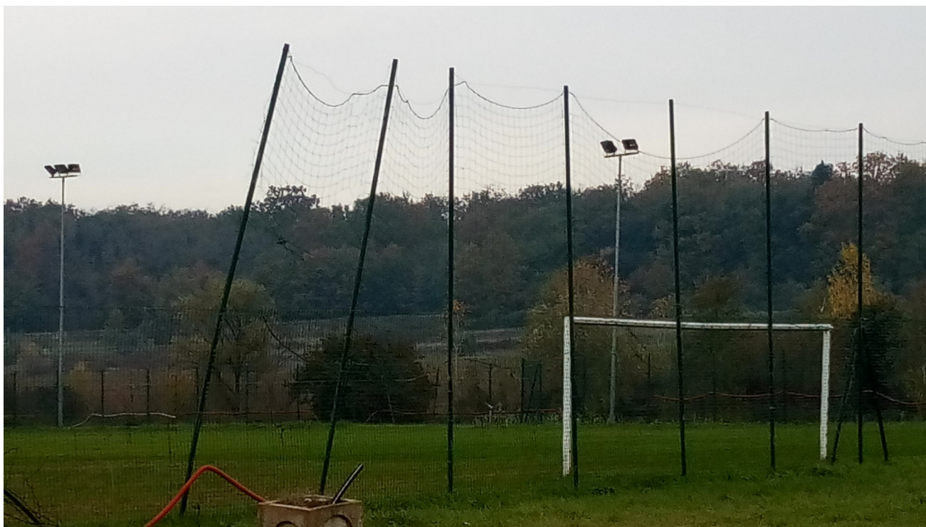
Veduta della situazione della recinzione parapalloni di altezza H= 6 m
