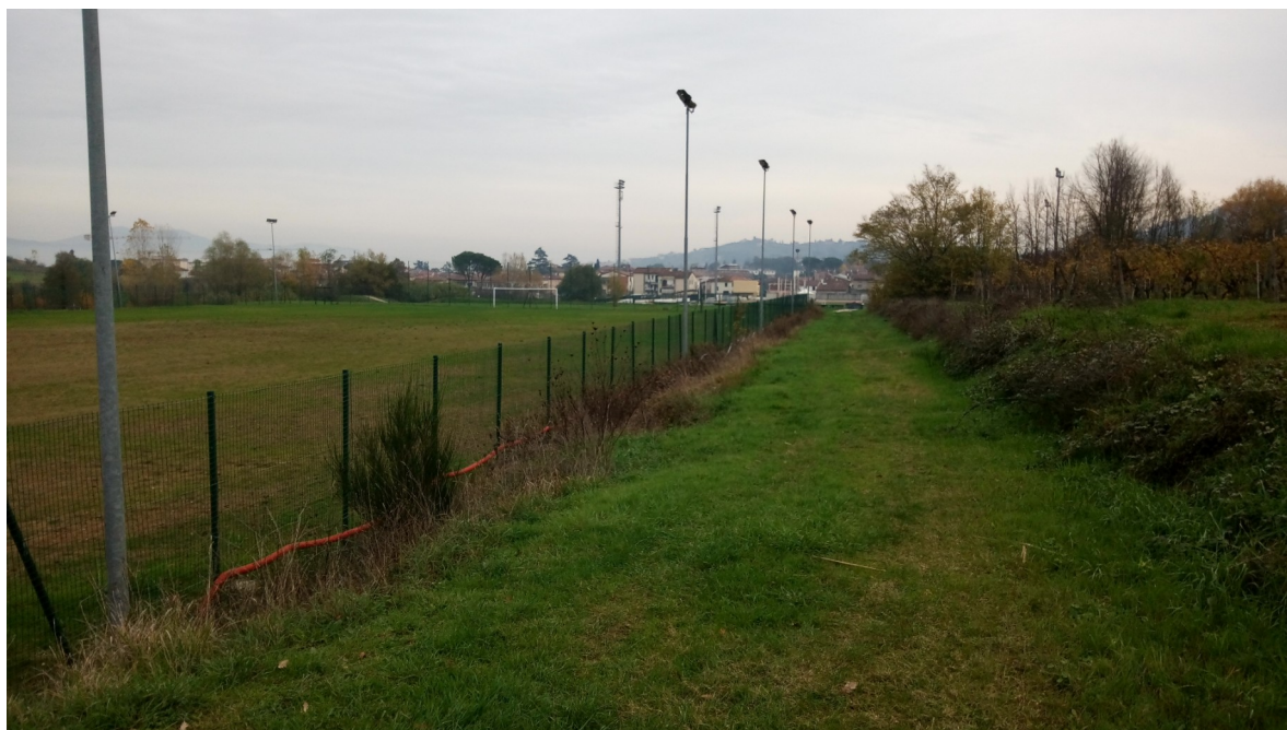
Veduta della viabilità di servizio lungo il lato sud – sud-ovest (vista da ovest verso est)
