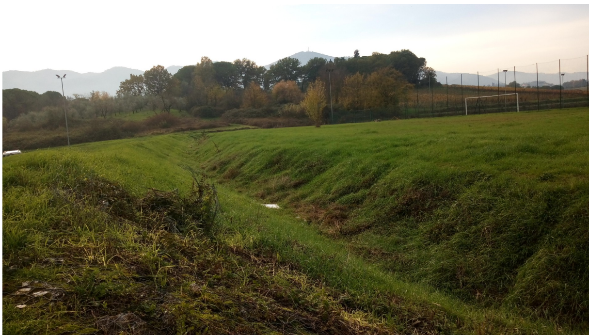
Veduta del fossato che delimita l'area di intervento verso est
