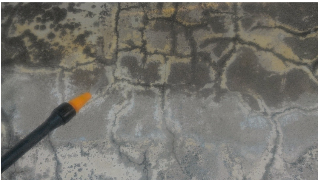
Foto 7 – Applicazione di biocida su intonaco esistente
