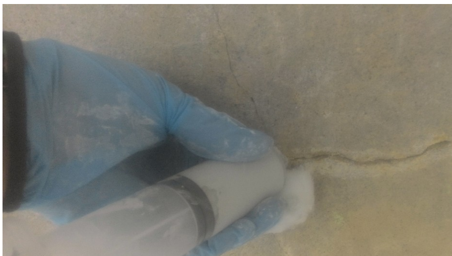
Foto 5 – Realizzazione iniezioni consolidanti
