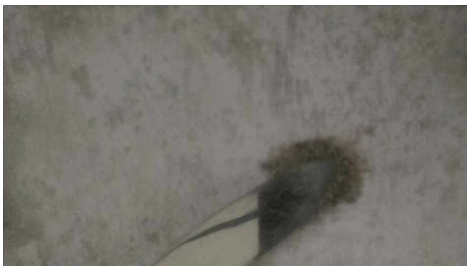
Foto 6 – Stuccatura del foro colmato con spatola
