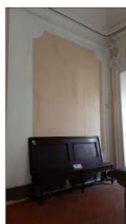
RESTAURO SPECCHIATURE A INTONACO
