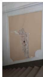
RESTAURO SPECCHIATURE A INTONACO
