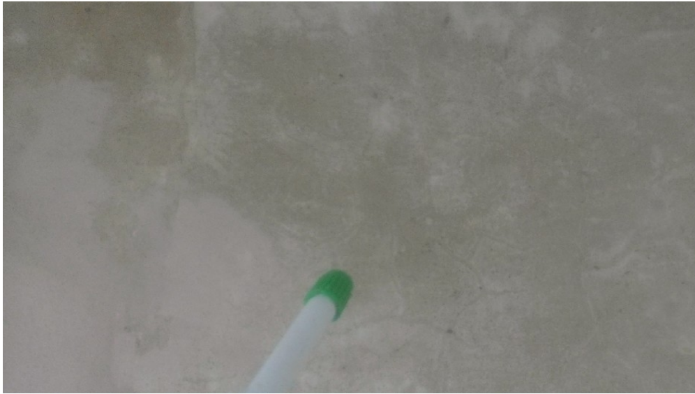
Foto 9 – Applicazione superficiale di NanoSilici
