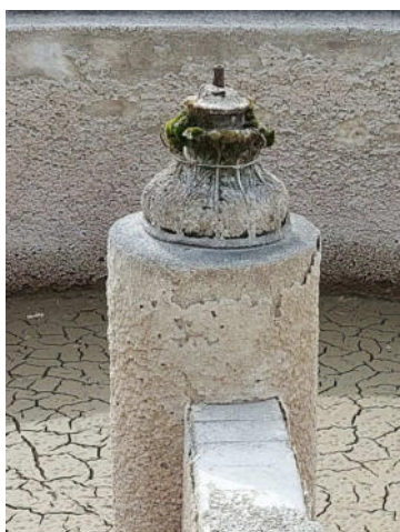
Foto 5: dettaglio del degrado sul supporto per i giochi d'acqua
