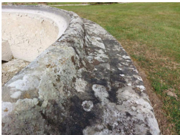
Foto 3: particolare del deposito sui bordi esterni
