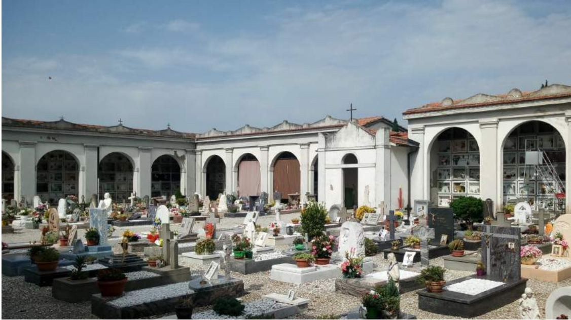
Veduta interna del Cimitero di Vignole
