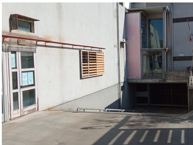
Accesso posteriore al livello seminterrato
