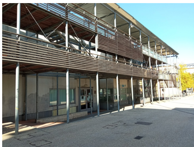
Ingresso principale al piano terra, Uffici SUAP
