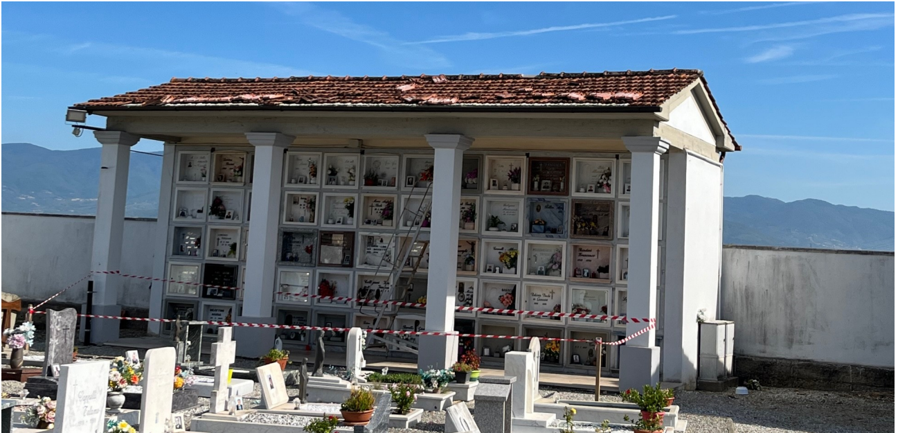
Fig.10 - Particolare fotografico cimitero Santonuovo individuazione intervento "D"
