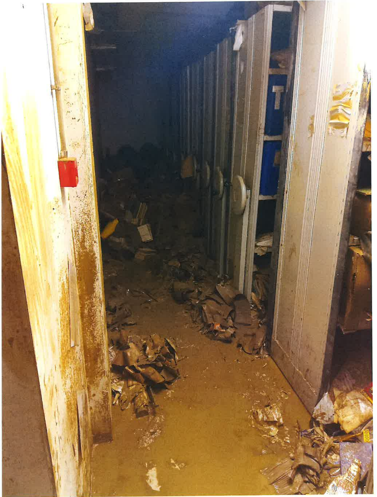
Fig. 3: a fine lavoro di sgombero per l'accesso all'Archivio Storico, 4/11/2023
