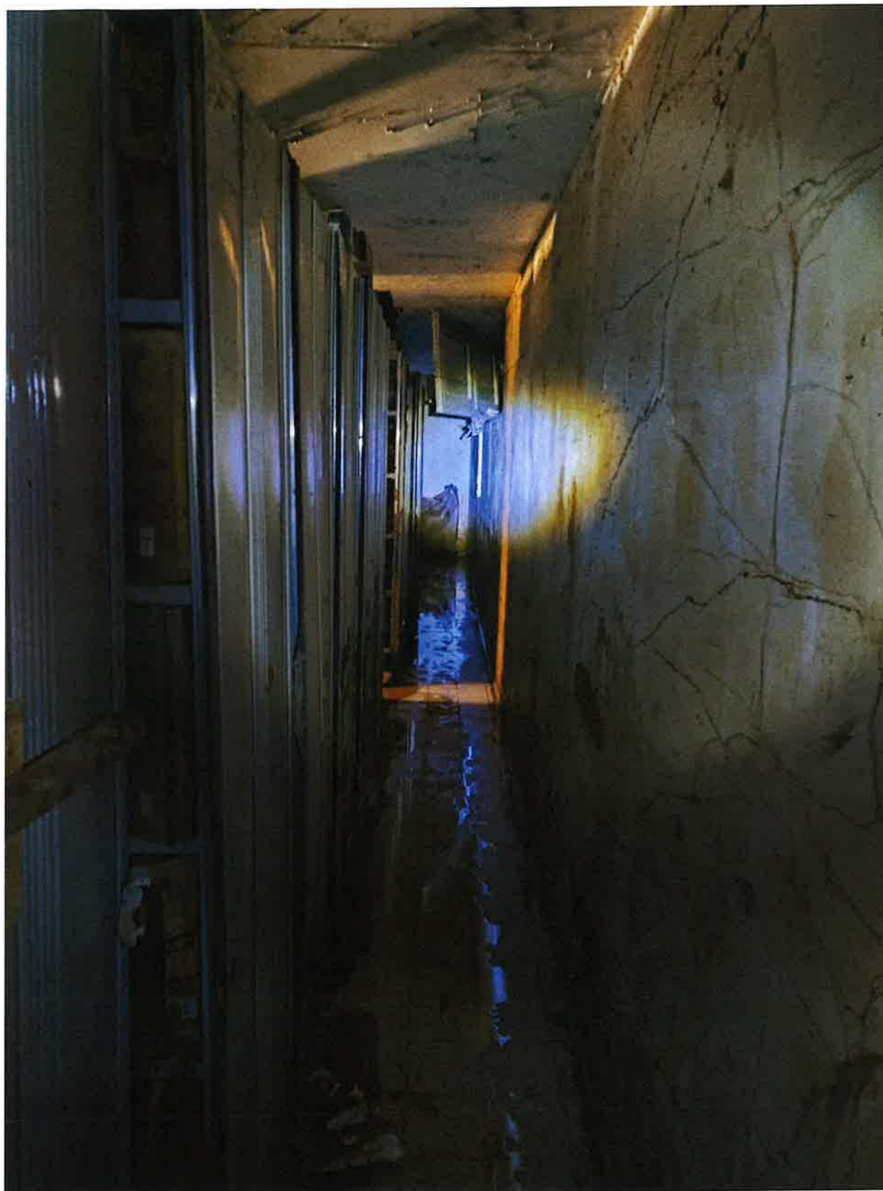
Fig. 1: dettaglio corridoio lato finestra dell'Archivio Storico. 4/11/2023
