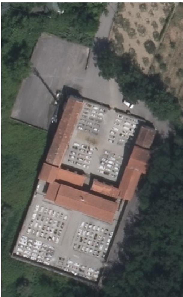
Vista aerea cimitero comunale di Valenzatico
