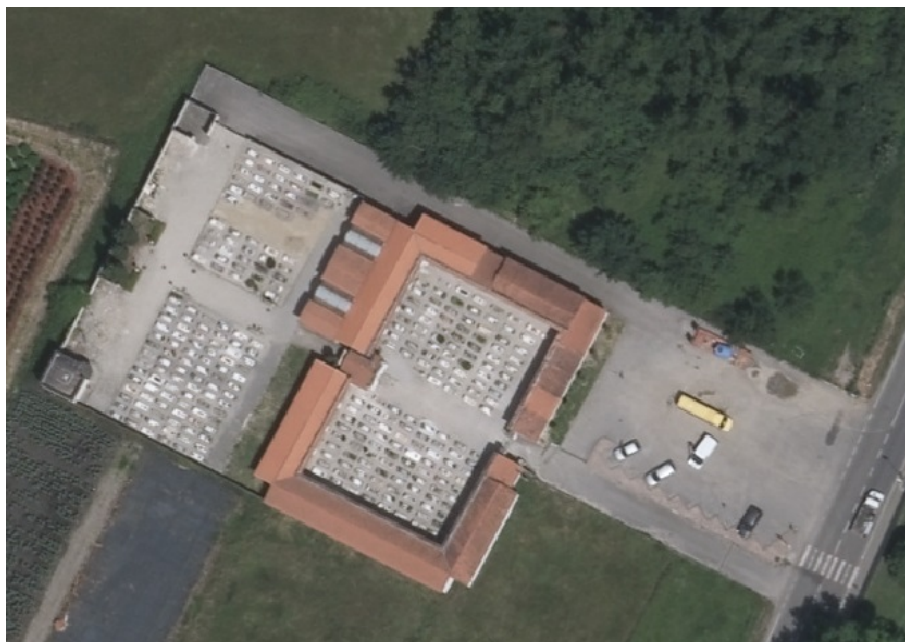
Vista aerea cimitero comunale di Vignole
